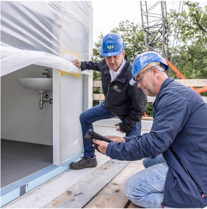
Medewerkers van WoonFriesland bekijken de kant en klare badkamer.
