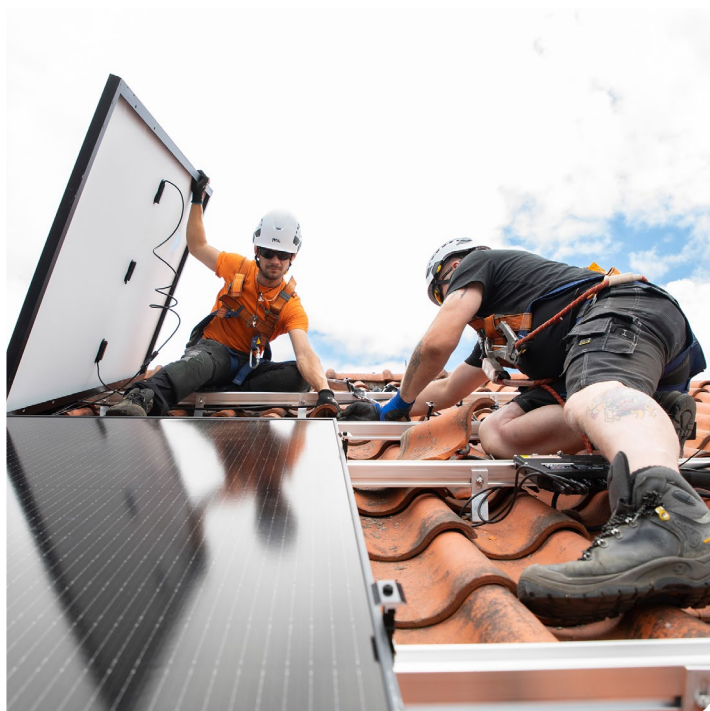
Plaatsing van zonnepanelen op een huurhuis in Drachten.
